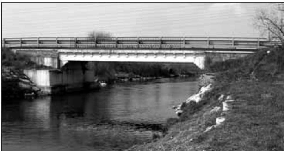
PONTE SUL LAMBRO TRA MEDIGLIA E CARPIANELLO DI SAN GIULIANO MILANESE
