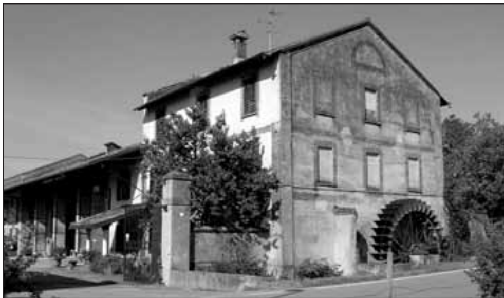
Il mulino di Robbiano, che conserva tuttora la gigantesca ruota idraulica in ferro del 1871, e all'interno i preziosi macchinari per la macinazione.
