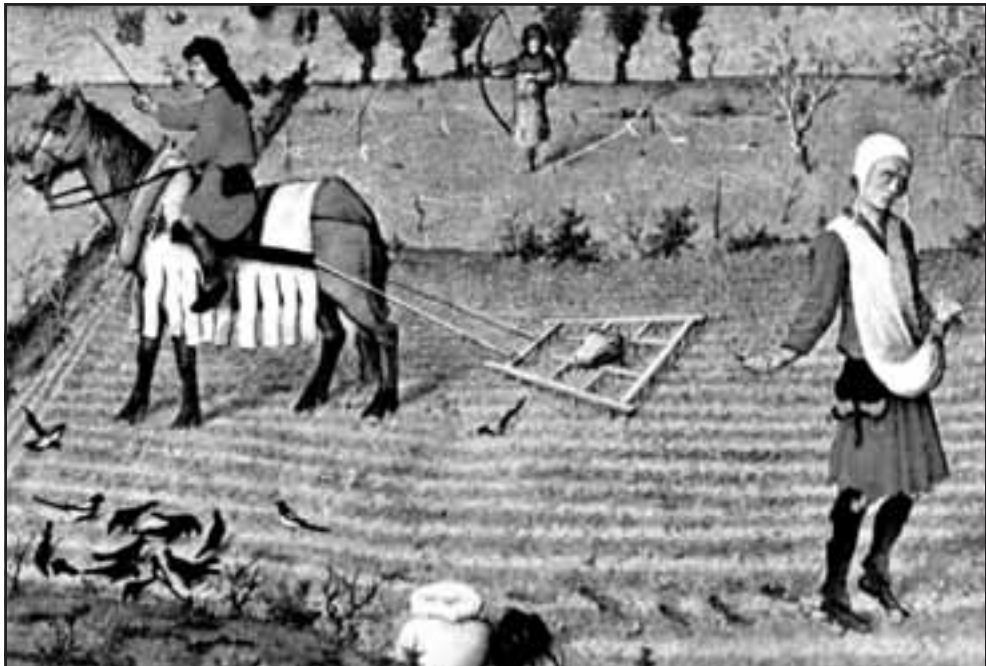
Lavori agricoli (dal Codice miniato Les très riches heures du Duc de Berry , secolo XV, Institut de France a Parigi).
