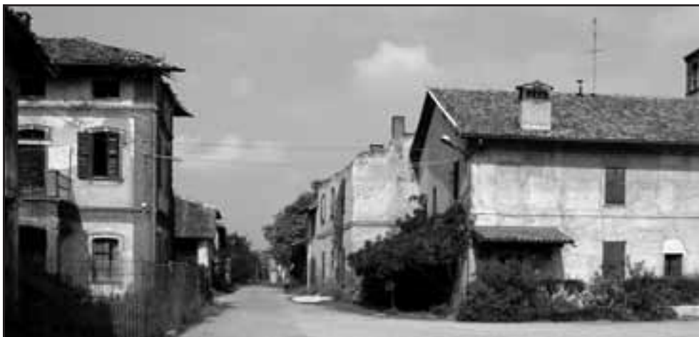
Vecchi fabbricati rurali alla Cascina di Triginto. A sinistra le ex abitazioni dei coloni, a destra la dimora padronale.
