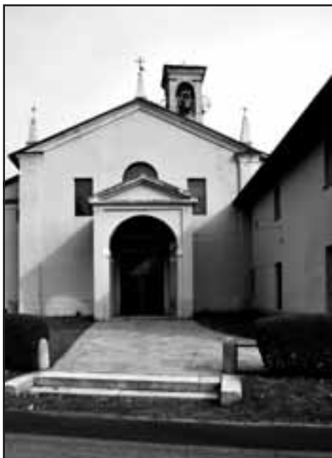
La chiesa di San Martino, situata all'ottavo miglio della strada romana Milano-Cremona ( in loco octavo ).
